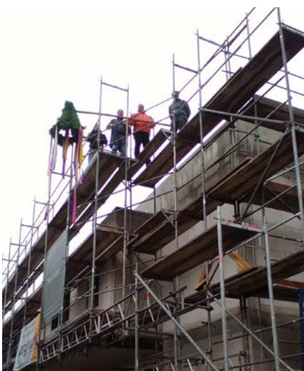
Ein großer Moment: Das Richtfest am 16.10.2015 lockte trotz des regnerischen Wetters viele auf die Baustelle. Die Kita-Kinder trugen drinnen ihr Lied vor: „Wer will fleißige Handwerker sehn“.
